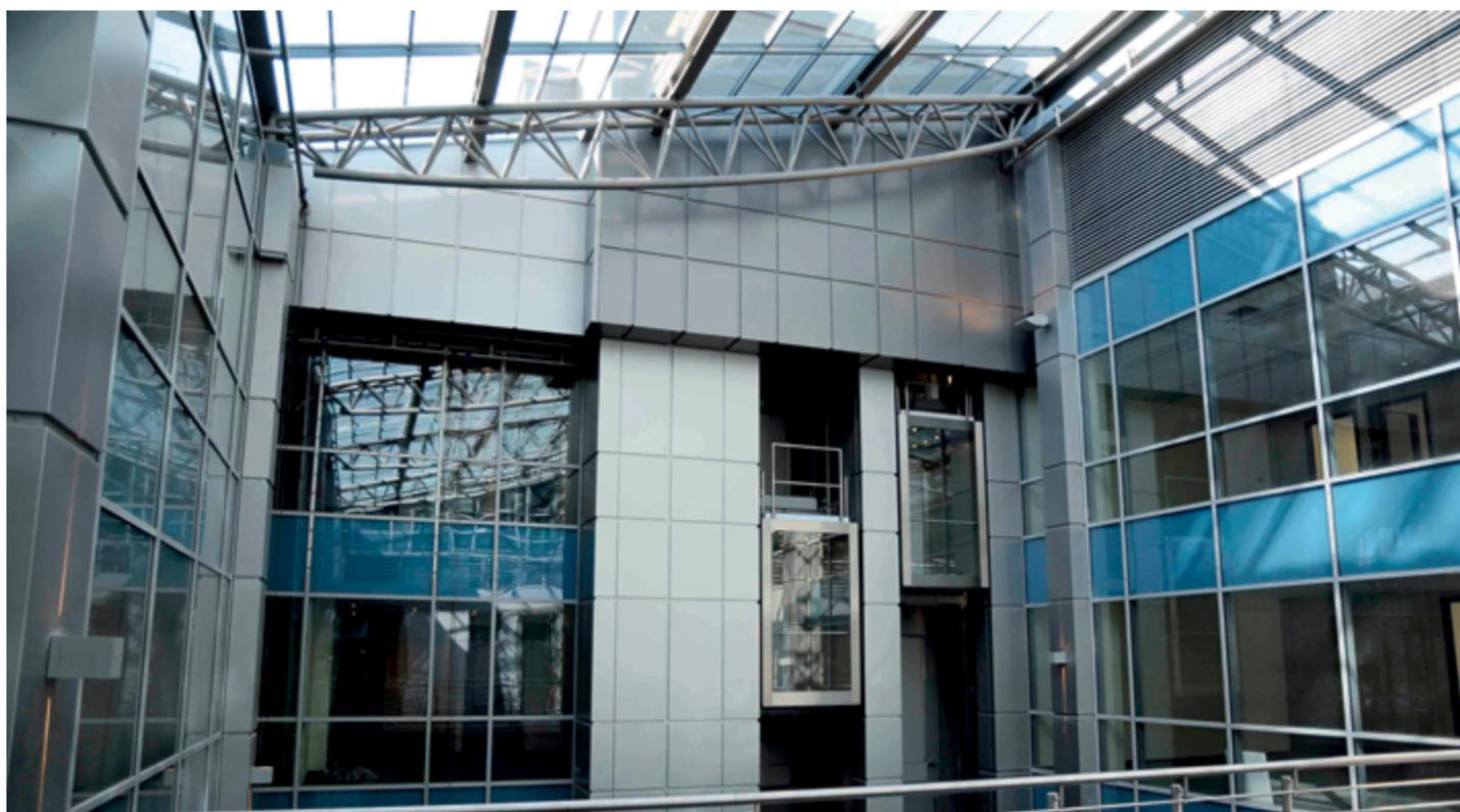
Le système à montants et traverses MB-SR50N EI sont destinés à réaliser des murs-rideaux coupe-feu légers et à remplissage, classés résistants au feu EI30, EI60 suivant la EN 1364-3 et EN 1364-1 et aux toits vitrés coupe-feu. Ce système prévient également la propagation du feu (NRO).
