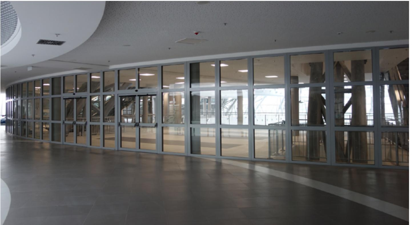
Le système **MB-118EI** est utilisé pour réaliser des cloisons coupe-feu intérieures ou extérieures, classées résistantes au feu EI 120. Il prévient également la propagation du feu (NRO). Sa structure est techniquement associée au système de cloisons coupe-feu avec porte **MB-78EI** en termes de composants communs : parclozes, matériaux de refroidissement, bandes intumescentes, joints d'étanchéité, accessoires, etc. La technologie de production et de montage est aussi la même.
