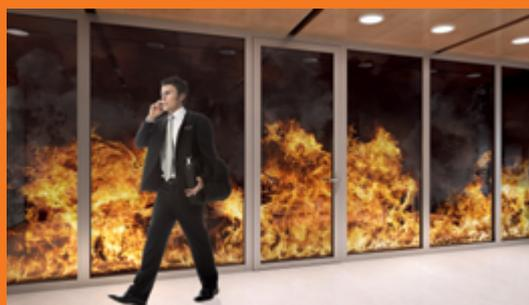
Réduction du rayonnement (W) est la capacité d'un composant ou d'une construction à maintenir l'intégrité d'un seul côté, pour réduire le risque de propagation du feu qui peut résulter d'un rayonnement thermique important, soit par un élément, soit de sa surface non-chauffée aux matériaux adjacents.
